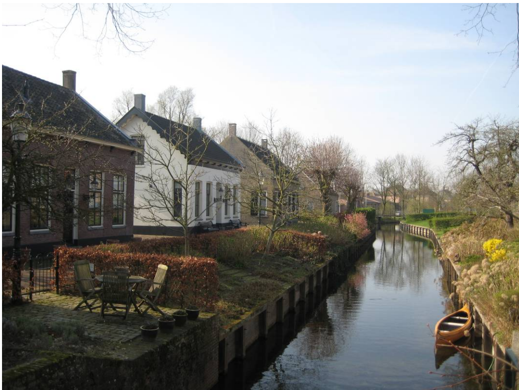
Voormalige turfvaart met begeleidende bebouwing
