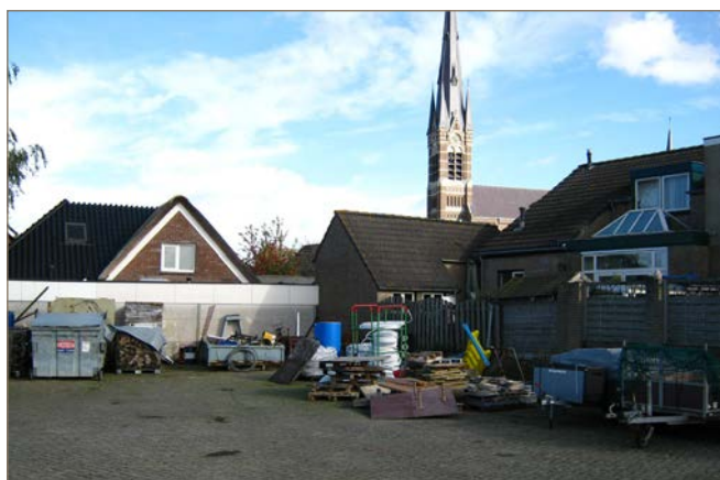
Figuur 13: Achterterrein Dorpsstraat 45-47
