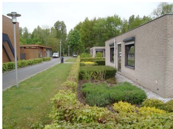
Foto 2. Voorzijde te slopen bebouwing in deelgebied A.
