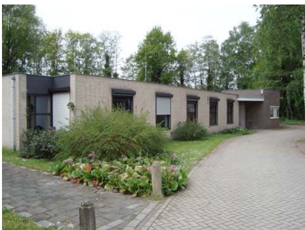
Foto 5. Deelgebied B met te slopen gebouw.
