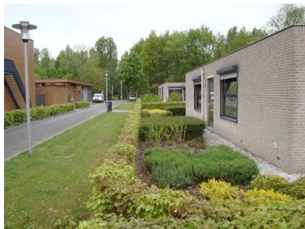
Foto 2. Voorzijde te slopen bebouwing in deelgebied A.
