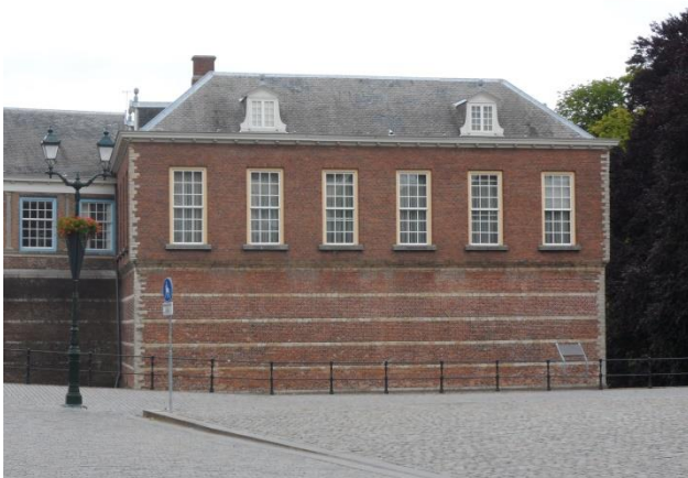
Het blokhuis bij de ingang van het kasteel van Breda, foto auteur 2014.
