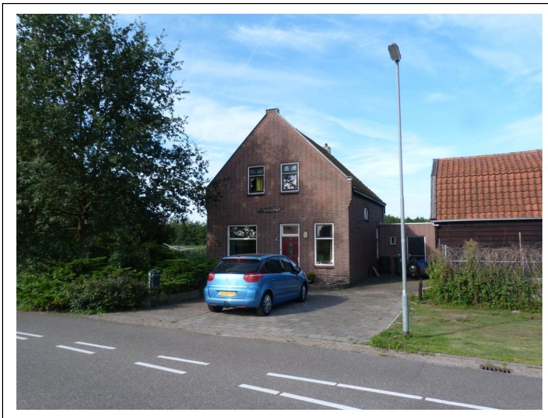
Foto 1. De te slopen woning met rechts een schuur van de naastgelegen roeivereniging.
