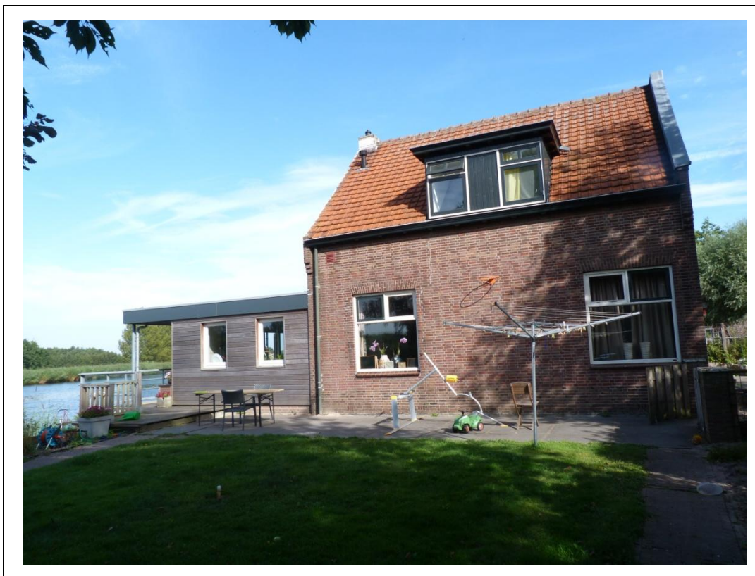
Foto 2. De te slopen woning met links de houten aanbouw boven de oever van de Mark.
