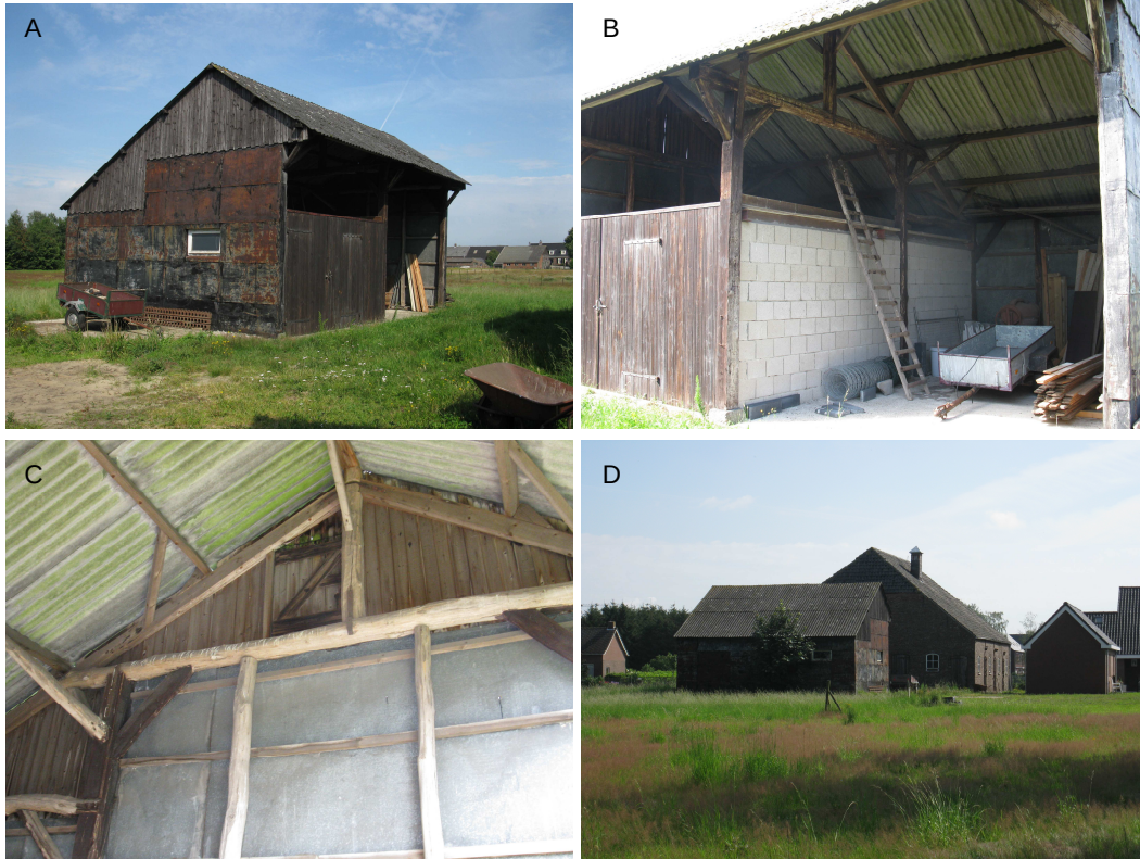
Foto 3. Open schuur aan Oude Kerkstraat 54 die functioneert als rustplaats voor de Kerkuil (A); Binnenkant van de open schuur aan Oude Kerkstraat 54 (B); Mestsporen van de Kerkuil op een dwarsbalk in de rustplaats aan Oude Kerkstraat 54 (C); Rustplaats met direct daarachter de dichte schuur aan Geraniumstraat 47, die (mogelijk) functioneert als verblijfplaats voor de Kerkuil (D).
