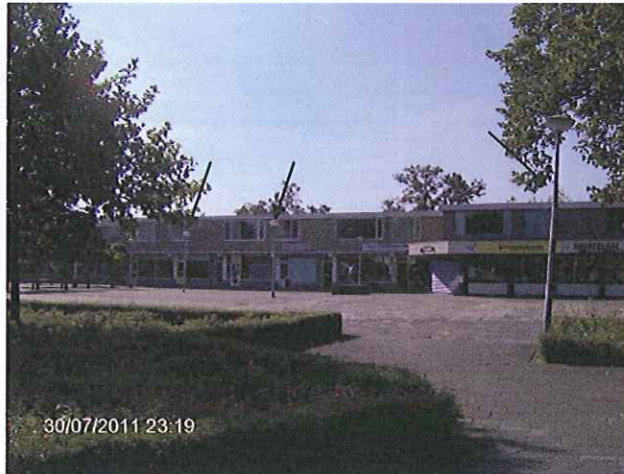
Foto 19: Aanwezige straatverlichting (ca. 3,5 m hoogte)
