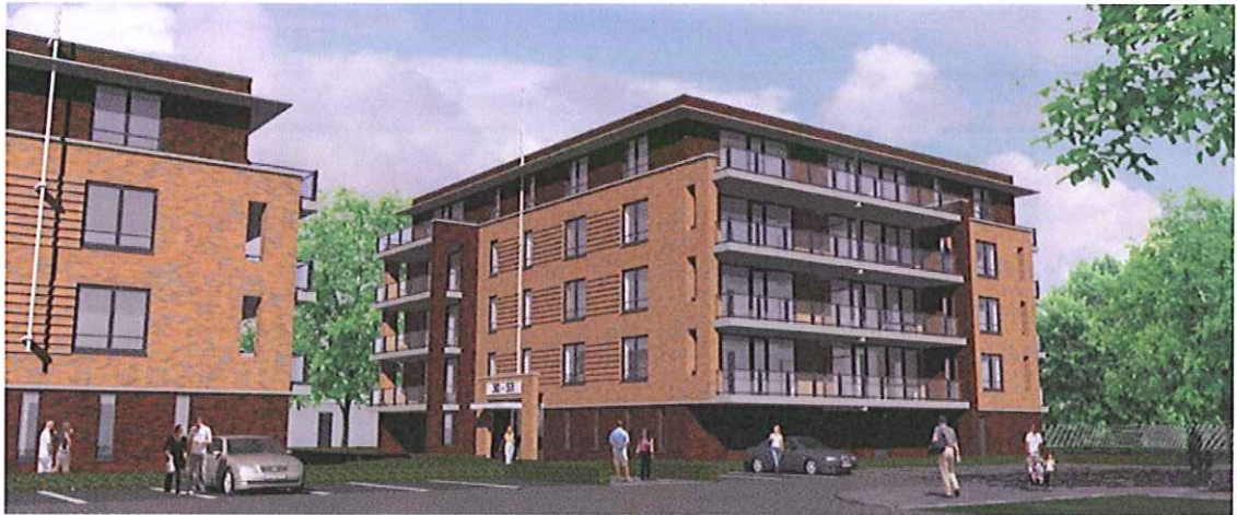
Figuur 6: Gebouw C (15,5 m hoog)
