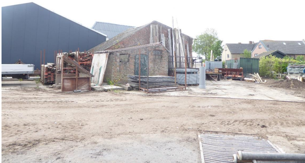
Figuur 6. Een deel van het terrein is verhard met betonnen platen, daarnaast bestaat de ondergrond uit aangereiden aarde.
