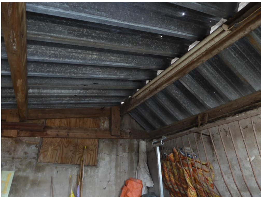
Figuur 5. De gebouwen konden volledig worden geïnspecteerd.
