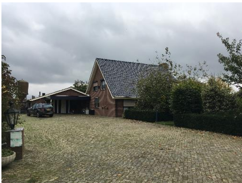
Figuur 1 De woning is opgetrokken uit gemetselde muren en bekleed met een pannendak.
