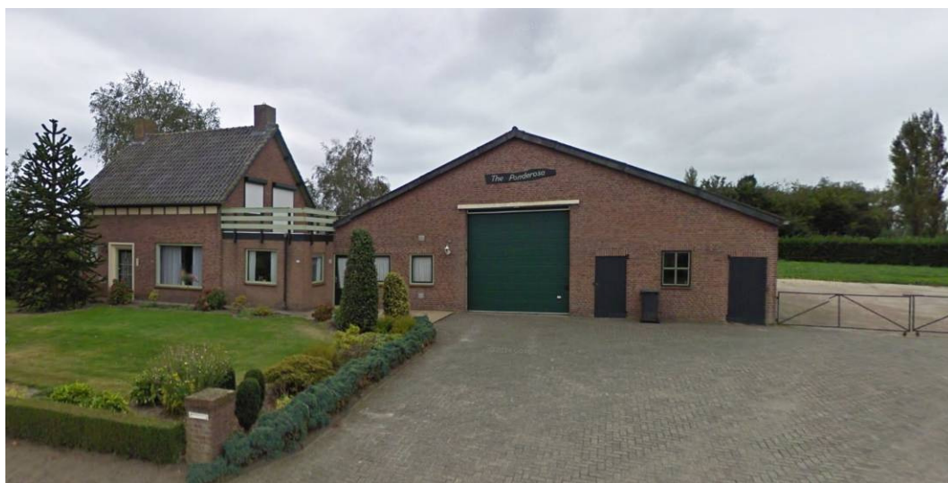
Afbeelding 6 - Zicht op het bedrijf vanaf de weg Stuivezandsestraat (september 2009); links is de woning te zien, in het midden de aangebouwde landbouwschuur.
