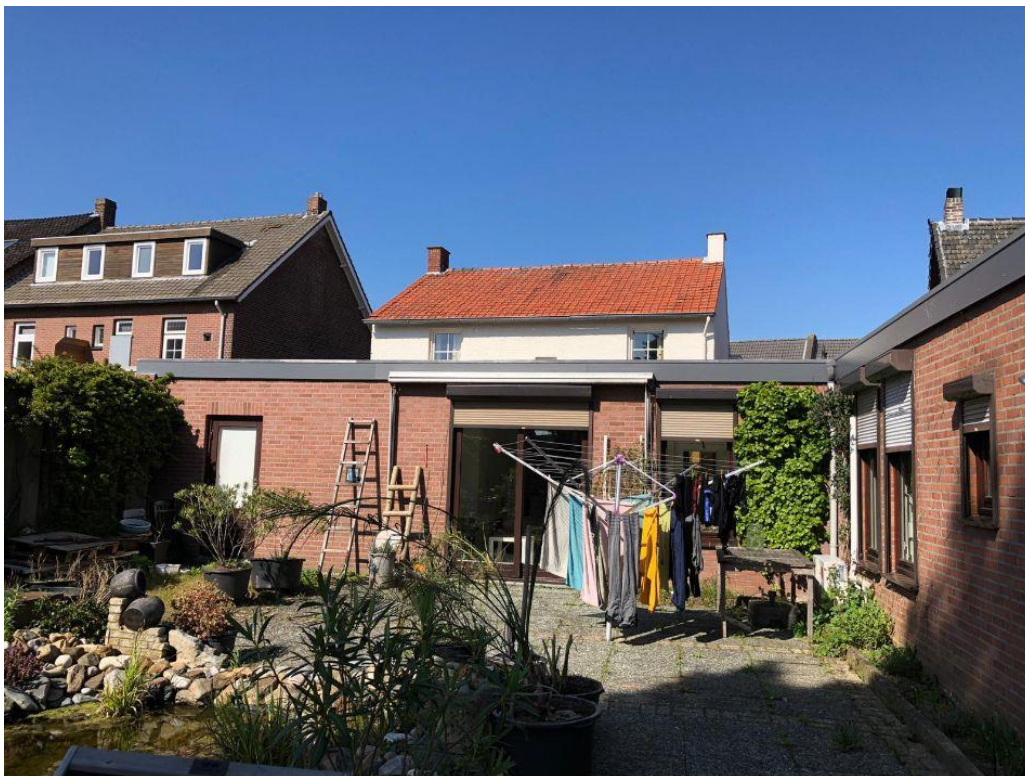
Graaf 21a, 23 en 23A, achterzijde pand
