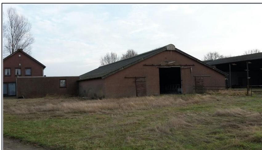
Figuren 8 en 9: Achtergevels
