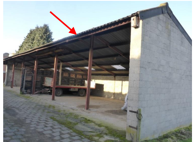
Foto 8 veldschuur 2: golfplaten, nokvorsten en windveer op dak
