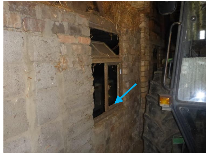
Foto 17 niet-asbesthoudende stopverf houten raamkozijn schuur
