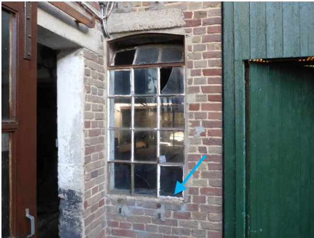
Foto 16 niet-asbesthoudende stopverf stalen raamkozijn schuur
