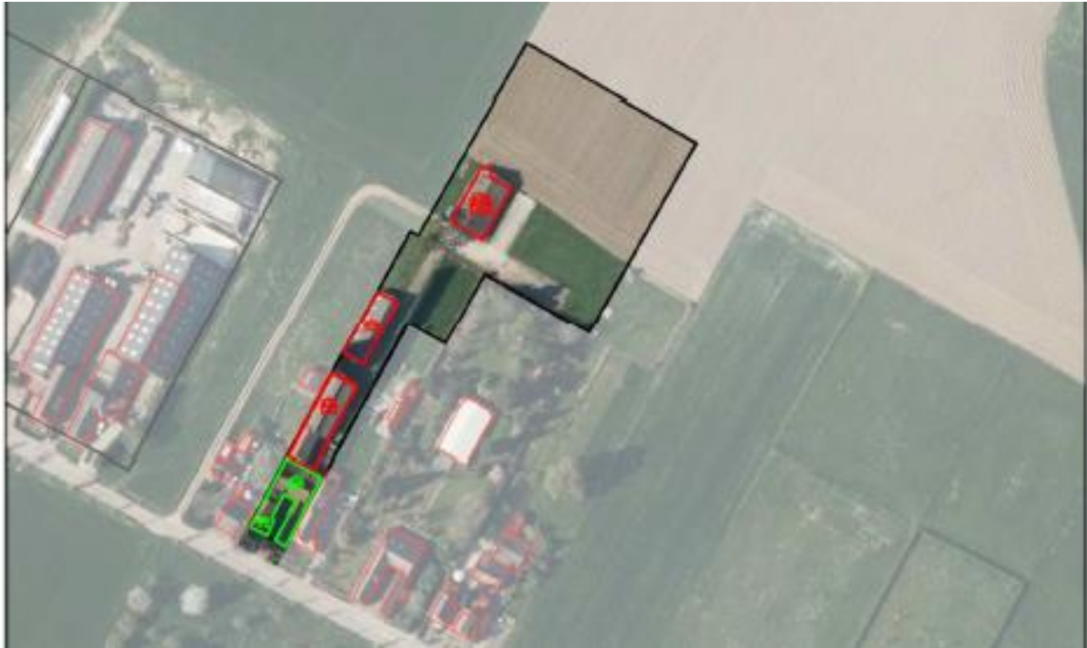
Figuur 1.2 De te slopen bedrijfsopstallen zijn rood omlijnd. De te behouden bedrijfsopstallen en bedrijfswoning zijn groen omlijnd. (Bron: www.pdokviewer.pdok.nl )
