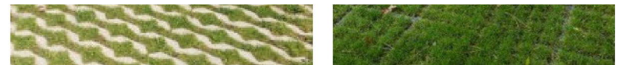
Afbeelding 36. Uitstraling grasbeton onderhoudspad van openbare weg naar klantstation en transformatoren.
