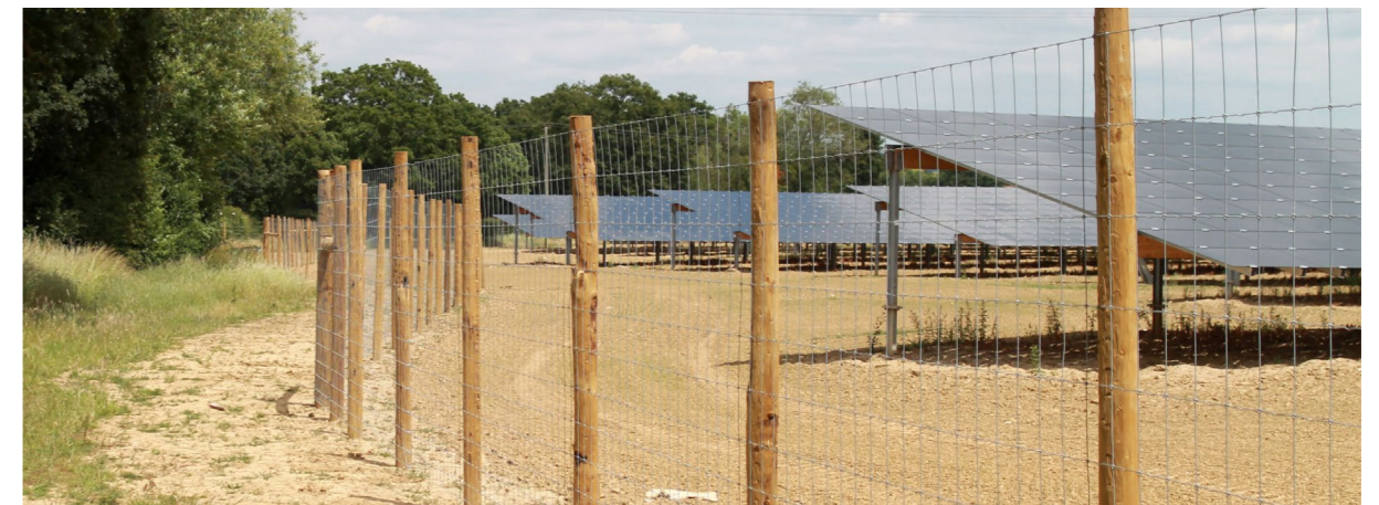
Afbeelding 32. Landschappelijk hekwerk: houten palen en schapengas om panelen en bouwwerken.
