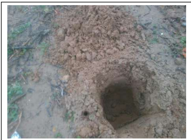
Foto 9. Opgegraven en gezeefd materiaal asbestinspectiegat 10
