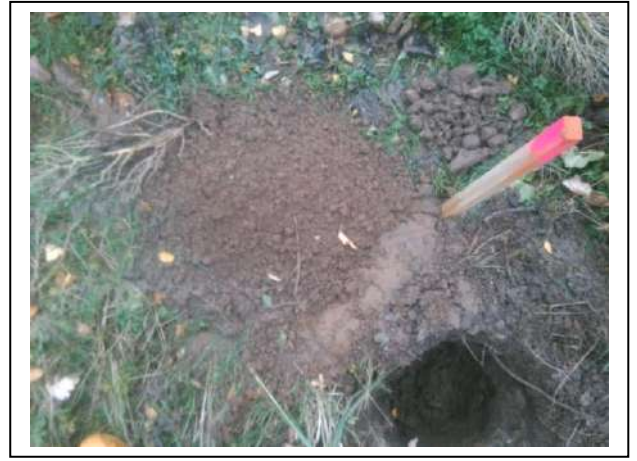
Foto 22. Opgegraven en gezeefd materiaal asbestinspectiegat 23
