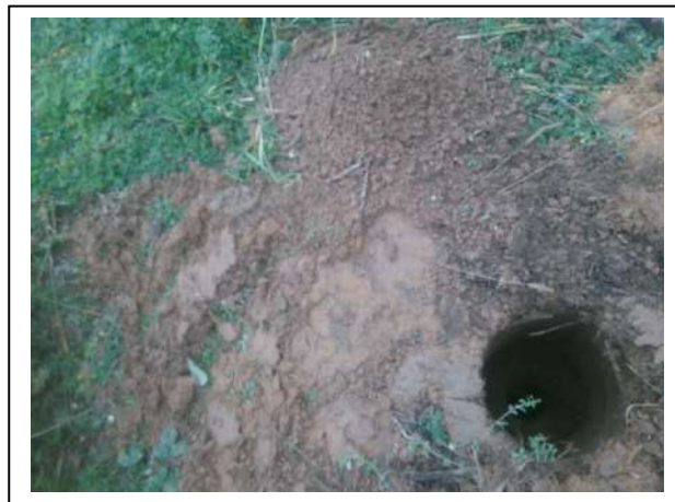
Foto 2. Opgegraven en gezeefd materiaal asbestinspectiegat 02
