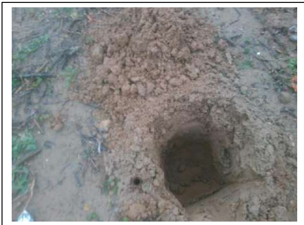
Foto 9. Opgegraven en gezeefd materiaal asbestinspectiegat 10
