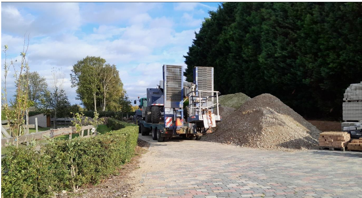
Afbeelding 13: Zicht op bedrijfsontsluiting achterzijde Veldweg aan de Berg
