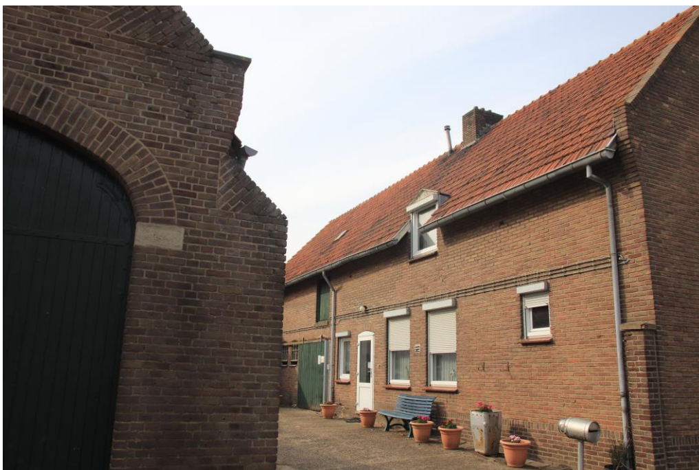
Foto 2: woongedeelte Oud Roosteren 15 met zicht op de zijkant van een van de monumentale gebouwen
