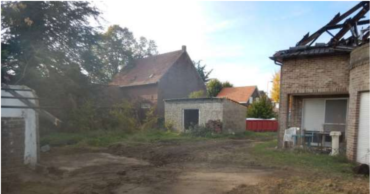
Figuur 17: Huidige situatie achterzijde van de beide panden. Een deel van de bovengrond is hier plaatselijk afgegraven, vermoedelijk in verband met een asbestsanering. 28
