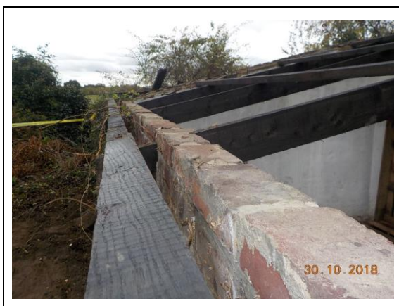
Foto 3: Locatie verwijderde bron 1-2
