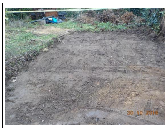
Foto 4: Locatie verwijderde bron 1-3
