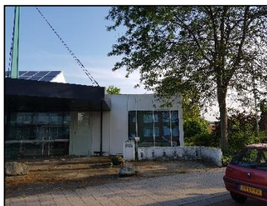
Figuur 3. Vooraanzicht kantoorpand.
