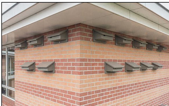
Figuur 18. Gierzwaluwnestkasten NK GZ 08 van Vivara Pro (bron: http://www.vivarapro.nl ).
