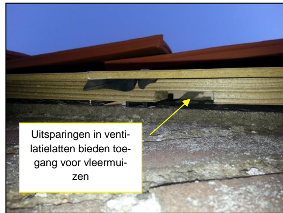
Figuur 20. Vleermuisvriendelijke afwerking dakrand
