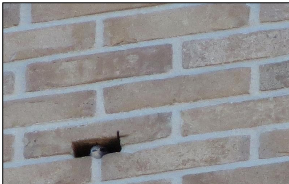
Figuur 16. Voorbeeld van onzichtbare gierzwaluw-inbouwsteen IB GZ 04 van Vivara Pro (bron: http://www.vivarapro.nl ).
