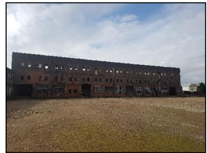
Figuur 5. Noordzijde voormalige dakpannenfabriek "De Valk".
