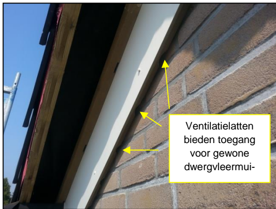
Figuur 19. Vleermuisvriendelijke afwerking dakrand.
