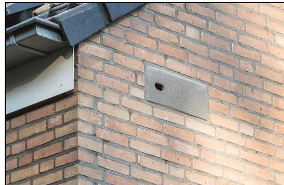
Figuur 15. Voorbeeld van zichtbare gierzwaluw-inbouwsteen IB GZ 03 van Vivara Pro (bron: http://www.vivarapro.nl ).
