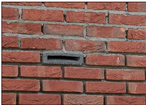
Figuur 21. Voorbeeld van vleermuis-inbouwsteen IB VL 04 van Vivara Pro (bron: http://www.vivarapro.nl ).
