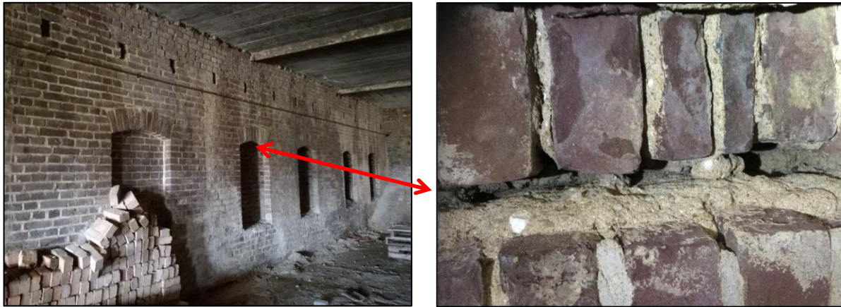
Figuur 11. Vastgestelde zomerverblijfsplaatsen van gewone dwergvleermuis in nissen in de binnenmuren van het gebouw.
