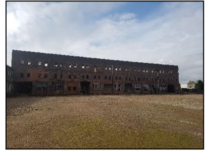
Figuur 4. Noordzijde voormalige dakpannenfabriek "De Valk".
