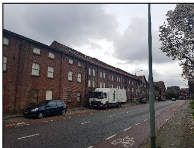
Figuur 5. Zuidzijde voormalige dakpannenfabriek "De Valk".
