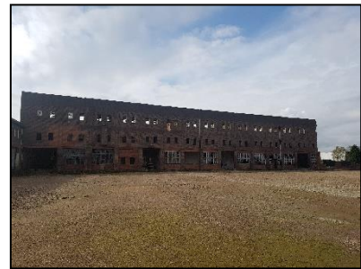
Figuur 5. Noordzijde voormalige dakpannenfabriek "De Valk".
