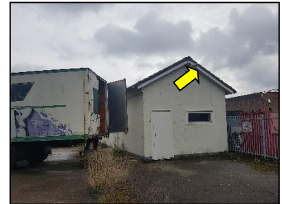
Figuur 12. Ruimte tussen gevelpan en windveer.
