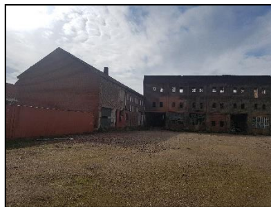
Figuur 4. Noordzijde voormalige dakpannenfabriek "De Valk".
