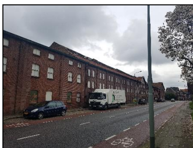
Figuur 6. Zuidzijde voormalige dakpannenfabriek "De Valk".
