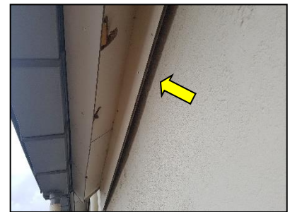
Figuur 15. Ruimte achter betimmering.
