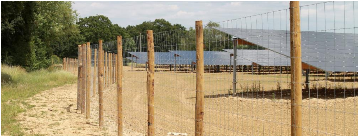
Figuur 6: Landschappelijk hekwerk, houten palen en schapengaas om panelen en bouwwerken
