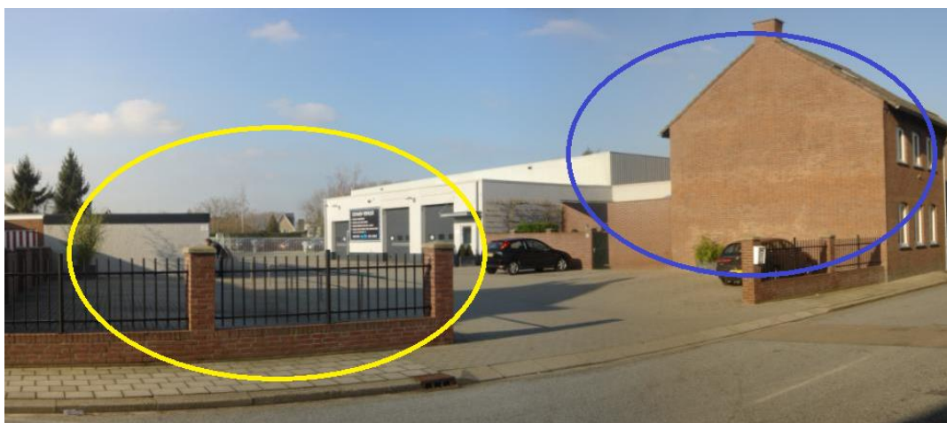
De Feurthstraat 81, 81a (geel) en de bedrijfswoning aan de Feurthstraat 83 (blauw)
