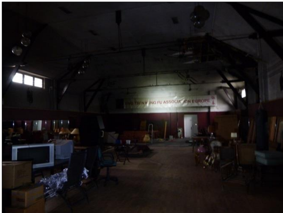
Figuur 5. Binnenzijde begaande grond
