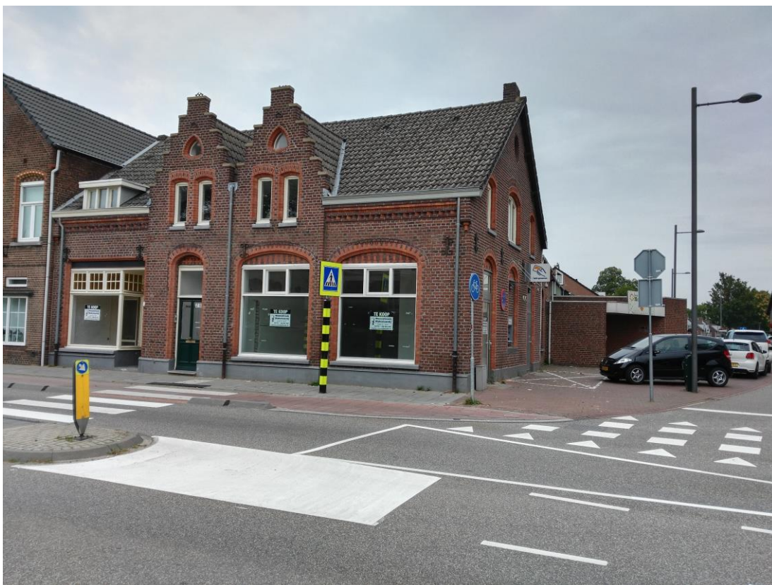
Foto 4: Kijkend in noordwestelijke richting (overzijde)
