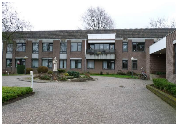
Fig. 4. Het tweede gebouw wat in pandig verbouwd gaat worden, aan de oostkant van het plangebied, in het midden van het totale complex.
