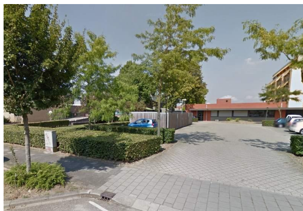
Fig. 8 De verbindingshal tussen de te verbouwen gebouwen en het nieuwere complex (bron Google Maps)
