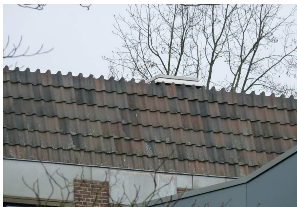
Fig. 6. Detail van het dak van het eerste gebouw. Foto genomen vanaf de Gasthuisstraat.
