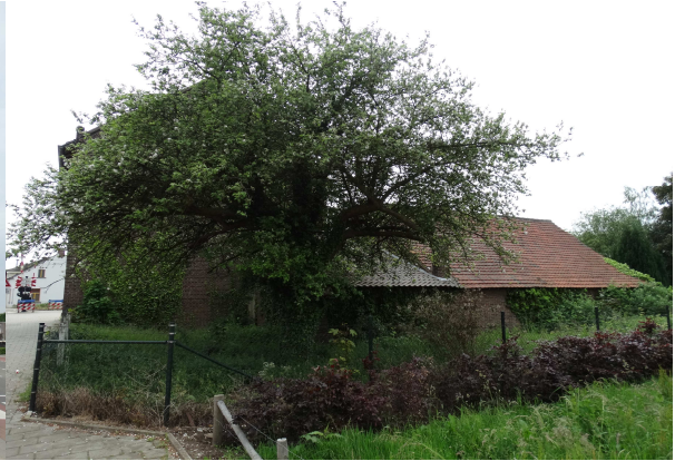
Figuur 4: Zijaanzicht de te slopen woning en beplanting. Foto genomen vanaf de westzijde
