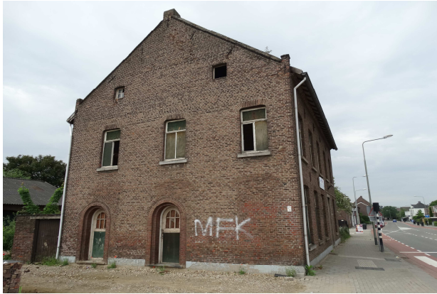
Figuur 3: Zijaanzicht de te slopen woning. Foto genomen vanaf de oostzijde
