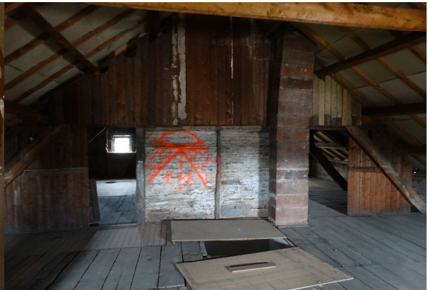
Figuur 6: Aanzicht zolder van de te slopen woning
