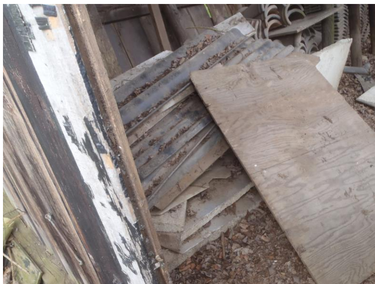
Foto 9. Opslag asbestverdacht materiaal
