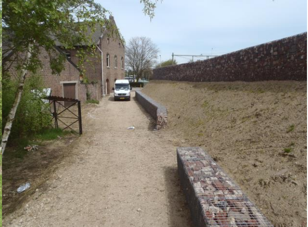
Foto 6. Oostelijk deels buiten onderzoekslocatie
