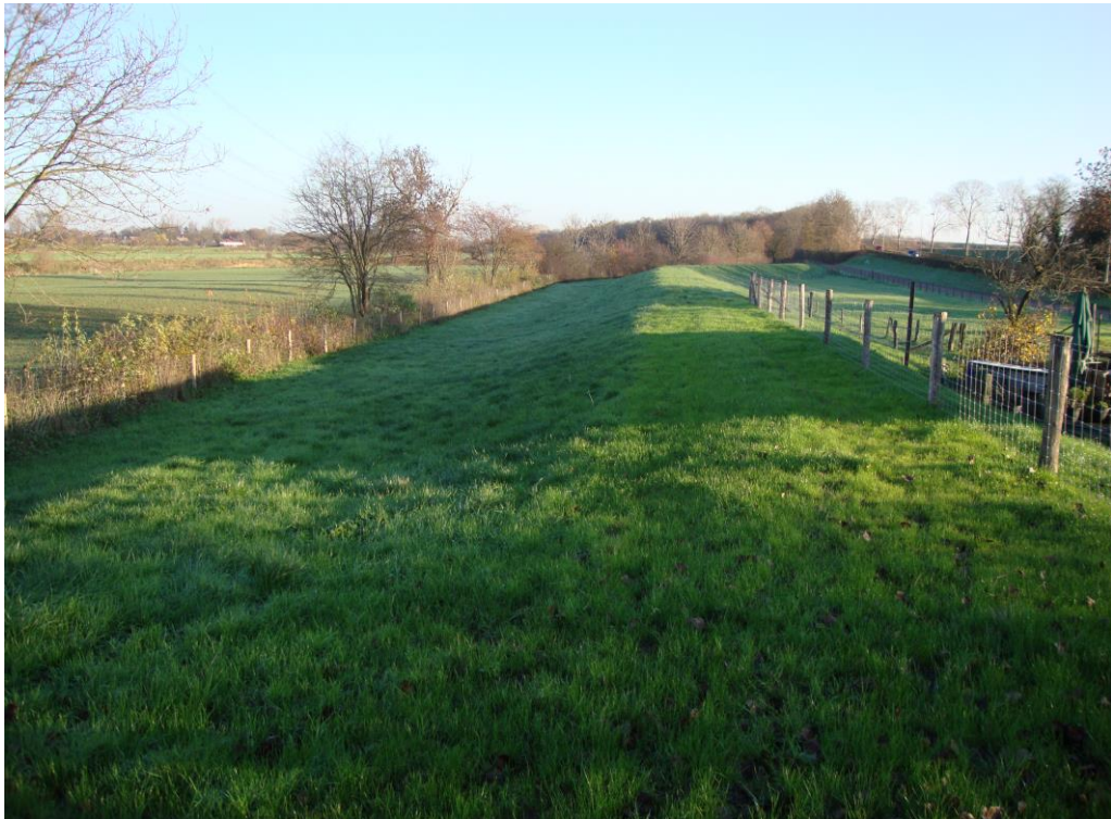
Waterkering tussen Aasterberg en de Maas, duidelijk herkenbaar in het landschap
