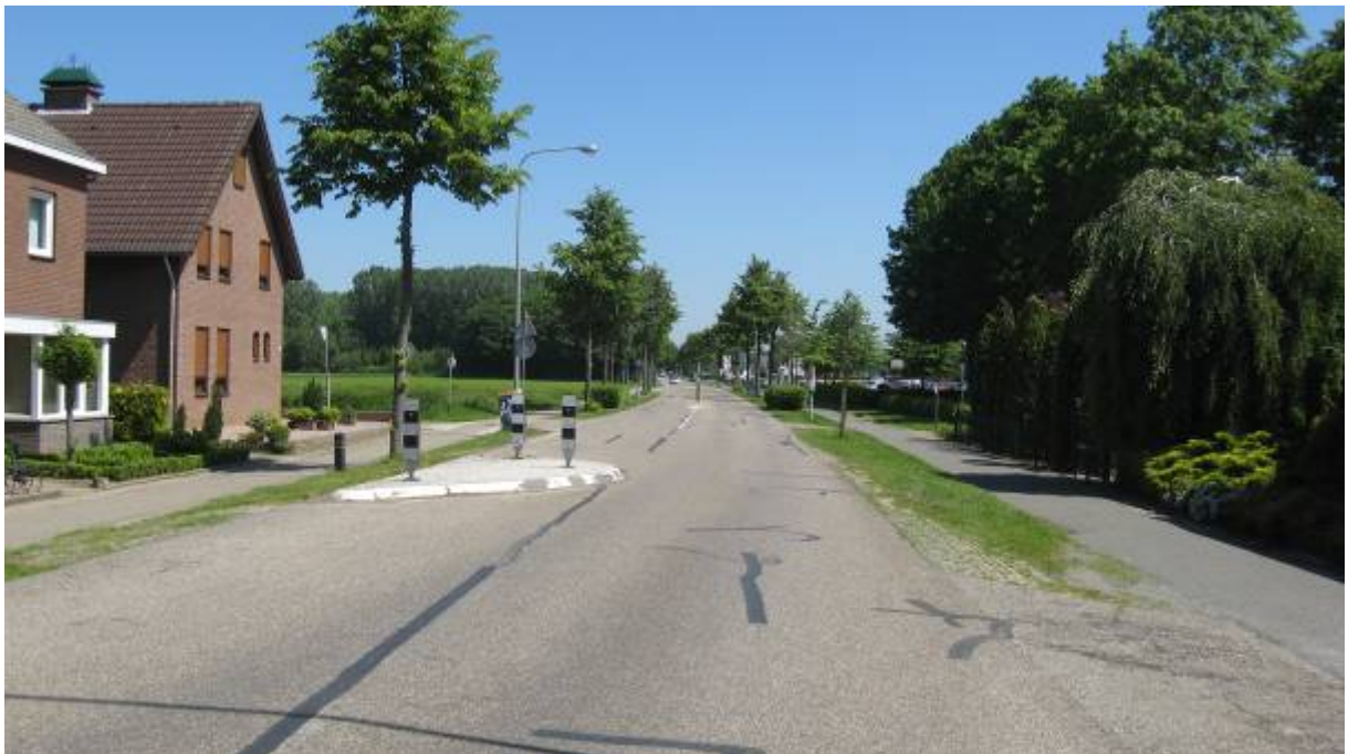
Foto 20: gebied 12, Oude rijksweg Noord, ter hoogte van kruising Louerlaan kijkend in noordoostelijke richting
