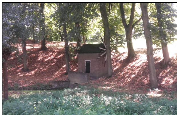
Afsluiter watergang bij één van de bastions
