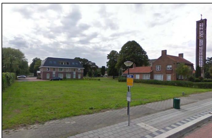
Aanzicht van de locatie Steenweg 43, gezien vanaf de oostzijde. De gronden zijn op dit moment braakliggend.
