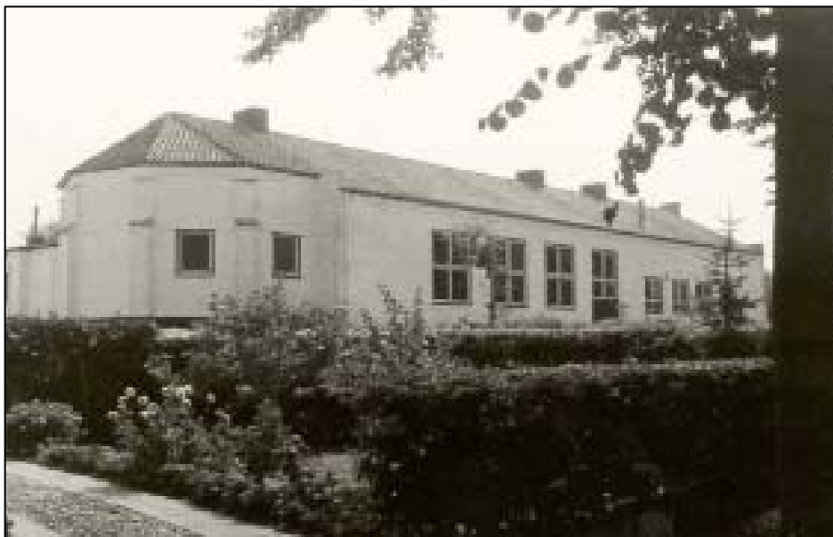
Het gebouw aan de Steenweg 52 met zijn kenmerkende vijfhoekige koorsluiting.
