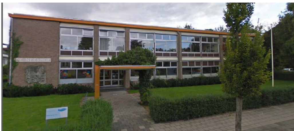
Afb 6: De te slopen bebouwing van de basisschool
