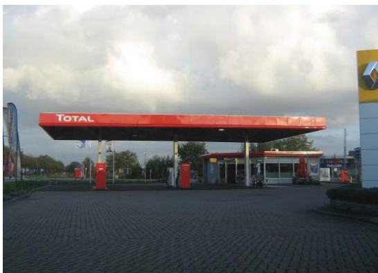
ad 3 Total Zuid. Randweg Moerdijk/Zevenbergen
