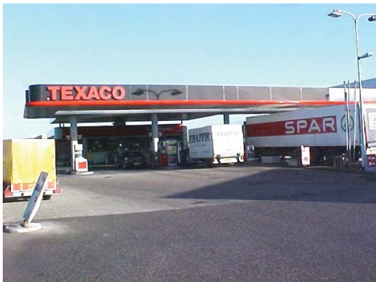
ad 14 Texaco Zuid. Randweg Moerdijk
