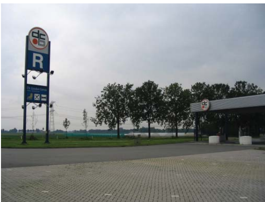
Entree en sign via Lapdijk
