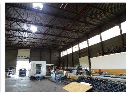
Foto 18: Pand 2 – interieur (opslag materialen).
