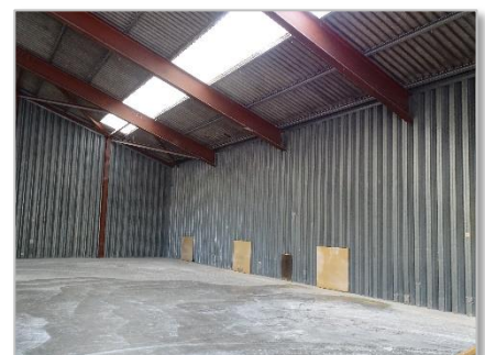
Foto 7: Pand 1 - graanopslag nu leeg.
