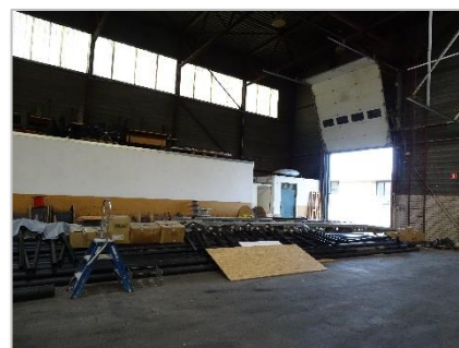
Foto 17: Pand 2 – interieur (opslag materialen).
