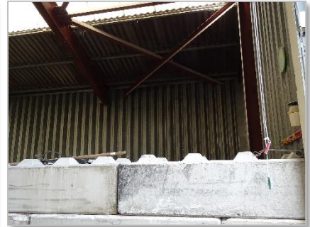
Foto 10: Pand 1 – graanopslag nu leeg.
