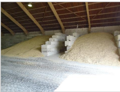
Foto 34: Pand 5 – nog in gebruik als graanopslag.
