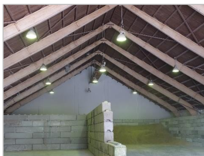
Foto 40: Pand 5 – nog in gebruik als graanopslag.
