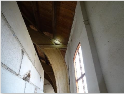
Foto 43: Pand 5 – binnenzijde aansluiting dak/gevel.
