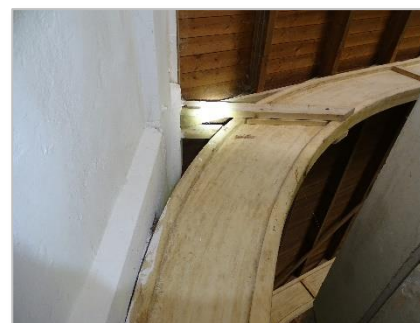
Foto 41: Pand 5 – binnenzijde aansluiting dak/gevel.
