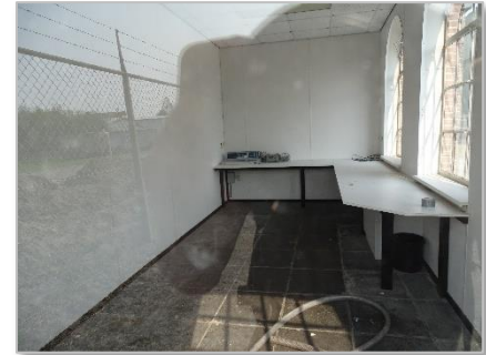
Foto 24: Pand 3 – huisje weegbrug interieur.
