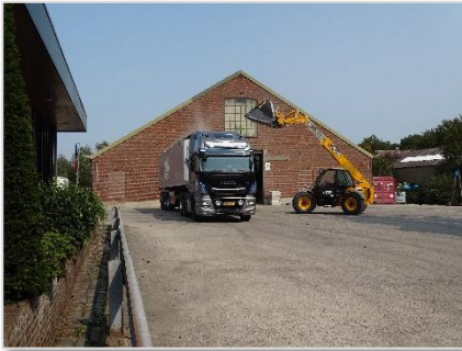
Foto 31: Pand 5 – nog in gebruik als graanopslag.
