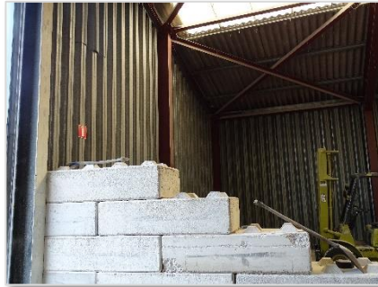
Foto 9: Pand 1 – graanopslag nu leeg.
