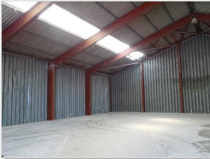
Foto 8: Pand 1 – graanopslag nu leeg.
