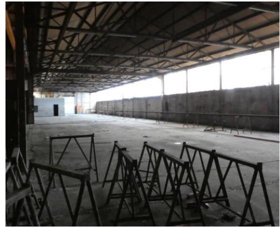
Afbeelding 5. Binnenzijde van één van de fabriekshallen binnen het fabriekspand (B).
