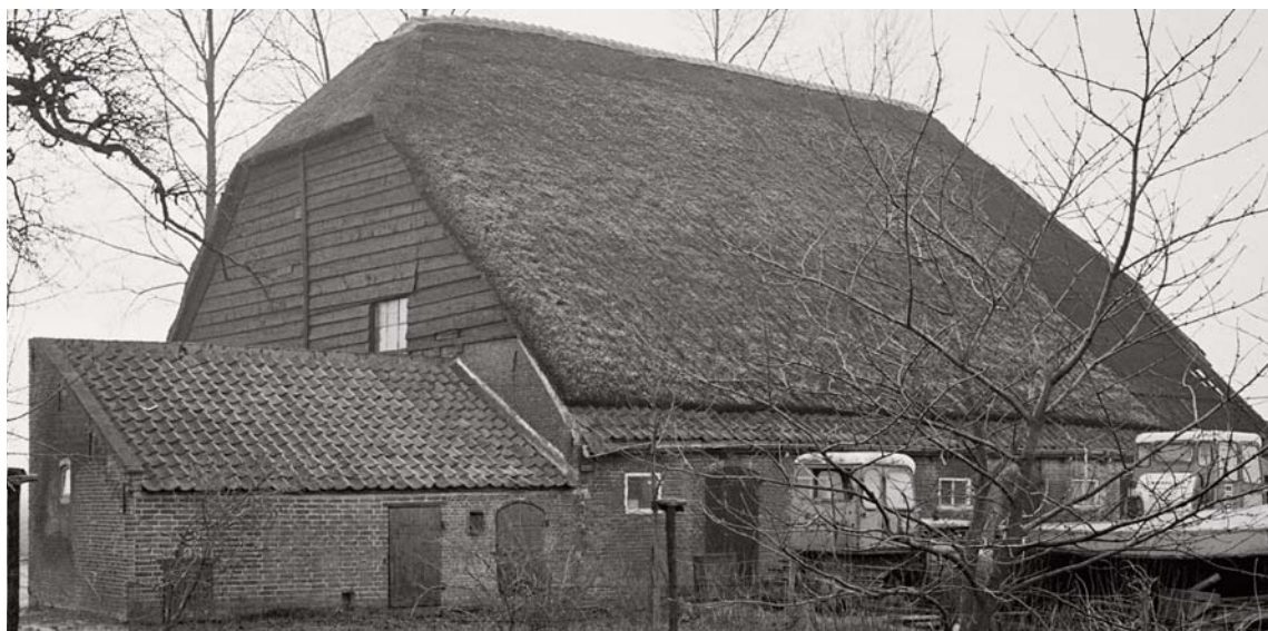
Afb. 12) (onder) Foto uit 1977 van de noordgevel en de oostgevel (links). (RCE)
