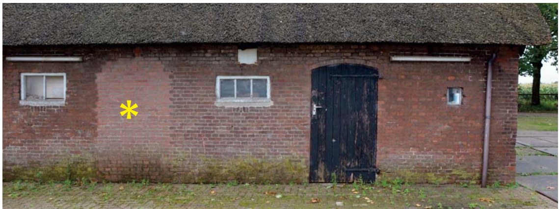
Afb. 11) (boven) Detail van de noordgevel met rechts de oorspronkelijke deur en het kleine oorspronkelijke venster en links een dichtgemetselde deuropening en latere betonnen stalramen.
