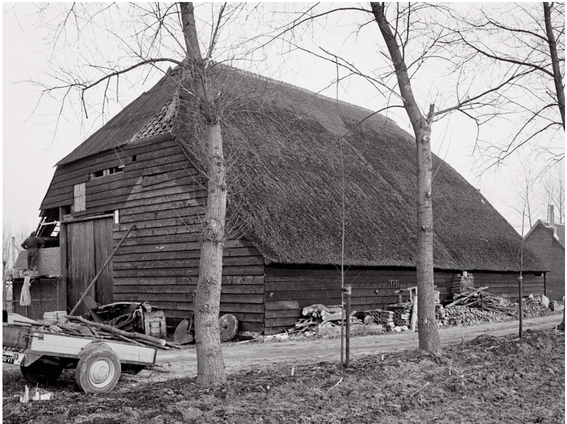
Afb. 15) (boven) Foto uit 1977 van de zuidgevel (rechts) en de westgevel (links). (RCE)
