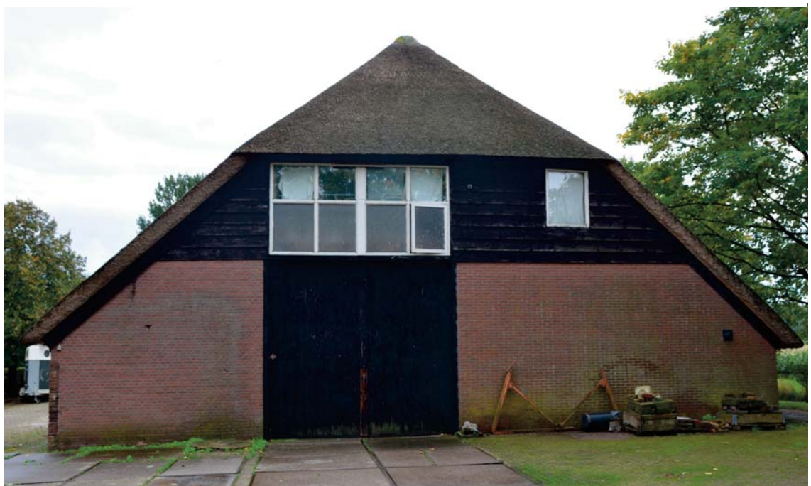
Afb. 16) (onder) De westgevel.
