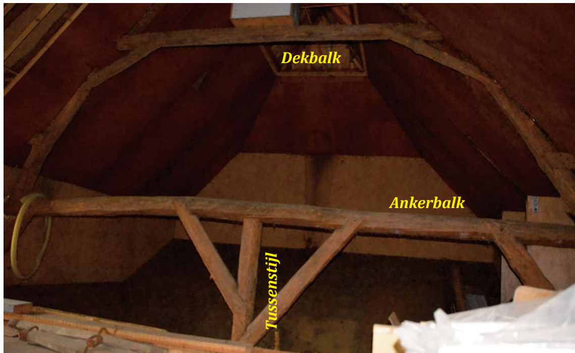
Afb. 19) (boven) De ankerbalk van gebint III met de tussenstijl en zijn schoren. Daarop staat het schaargebint.
