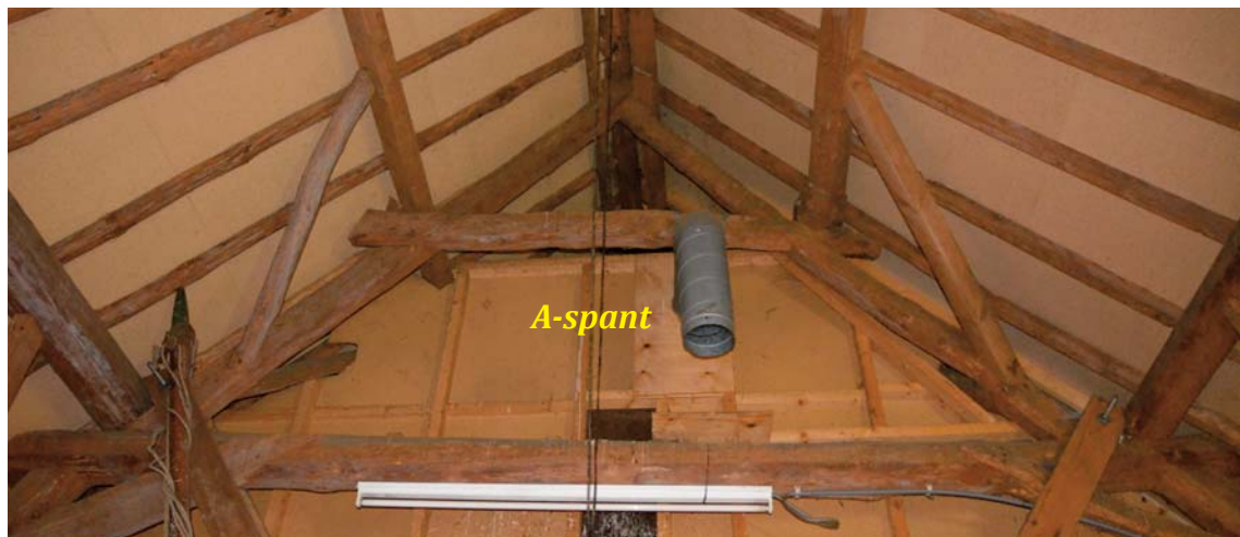
Afb. 20) (onder) Het A-spant op het schaargebint van gebint II.
