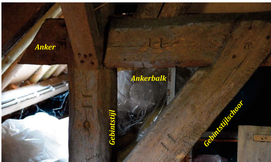
Afb. 25) (onder) De telmerken op gebint II. Links steekt de ankerbalk uit buiten de gebintstijl.
