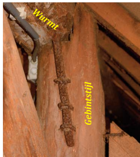
(onder) Het smeedijzeren anker in ge- bint II dat de gebintstijl en de wurmt onderling verbindt.
