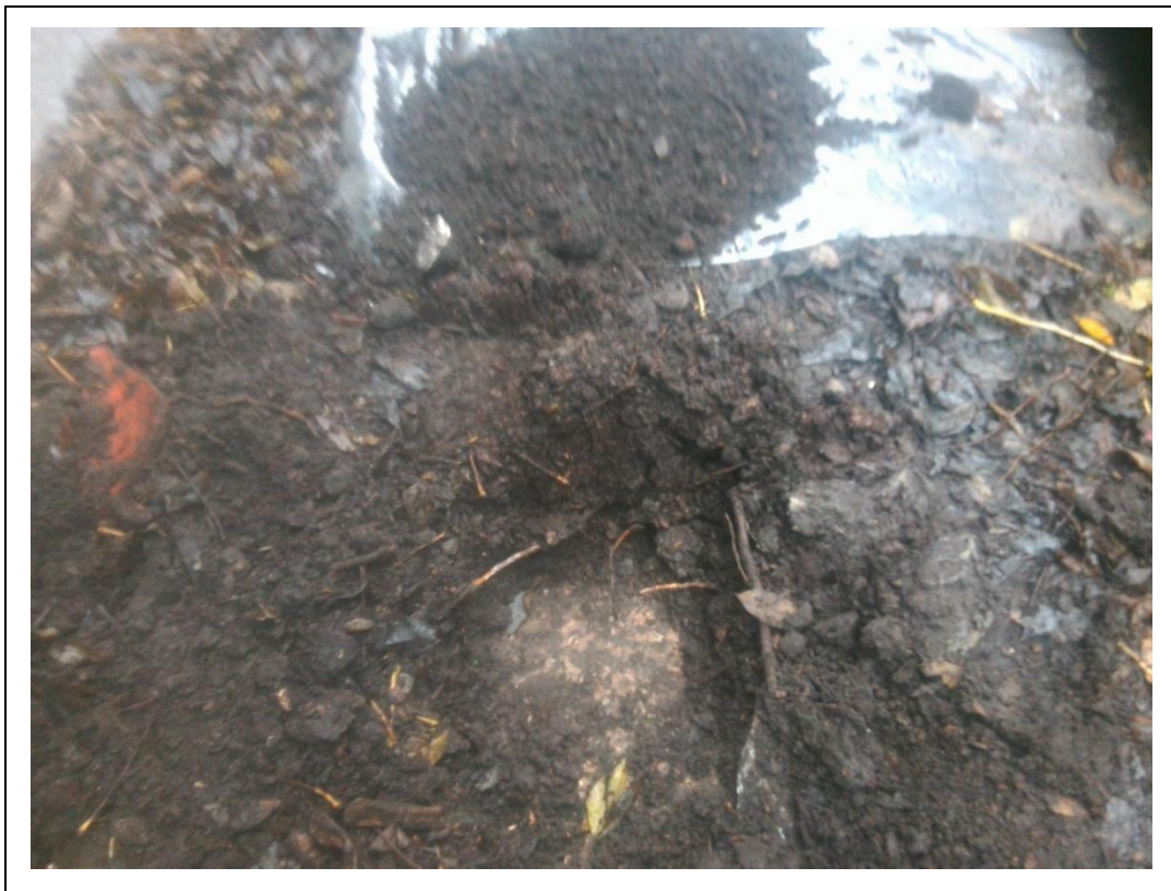
Foto gat en opgegraven materiaal ASB03.
