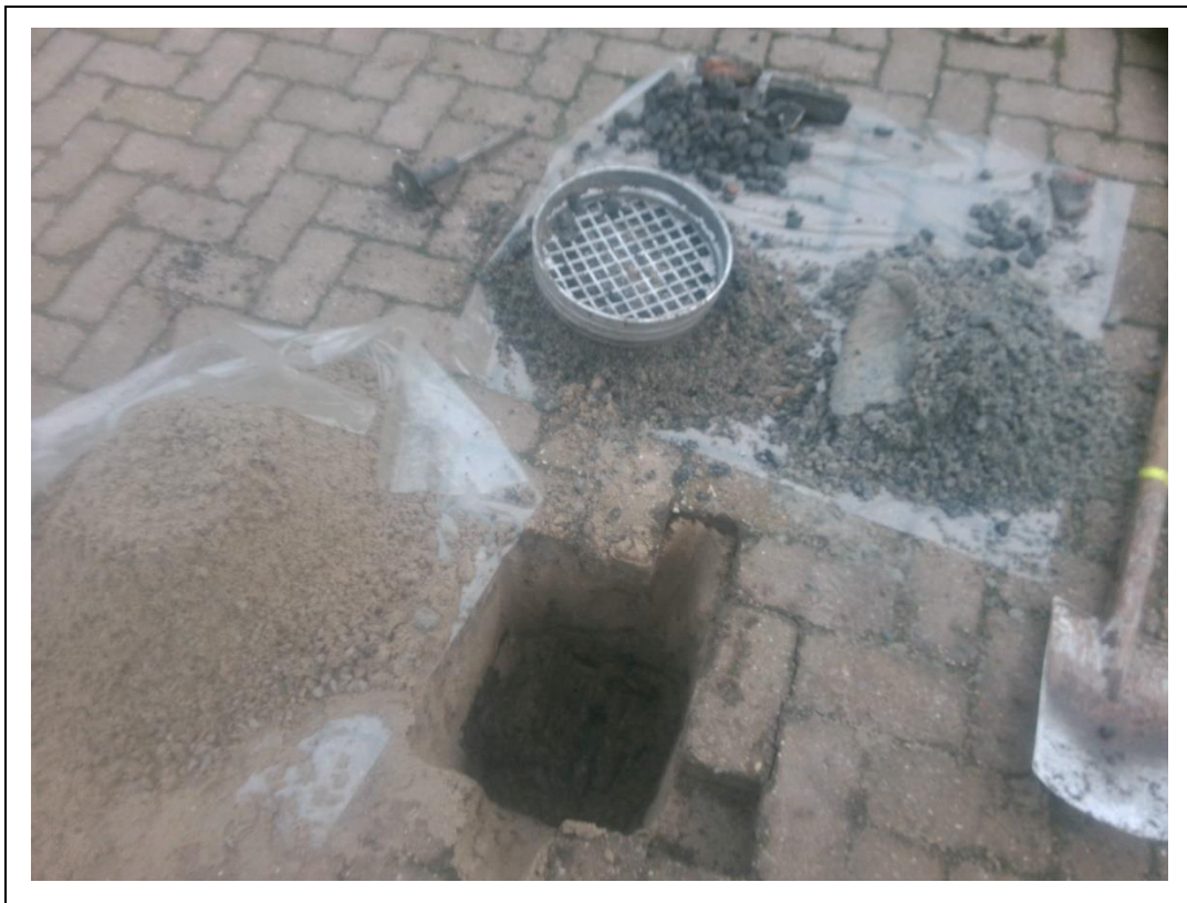
Foto gat en opgegraven materiaal ASB01.
