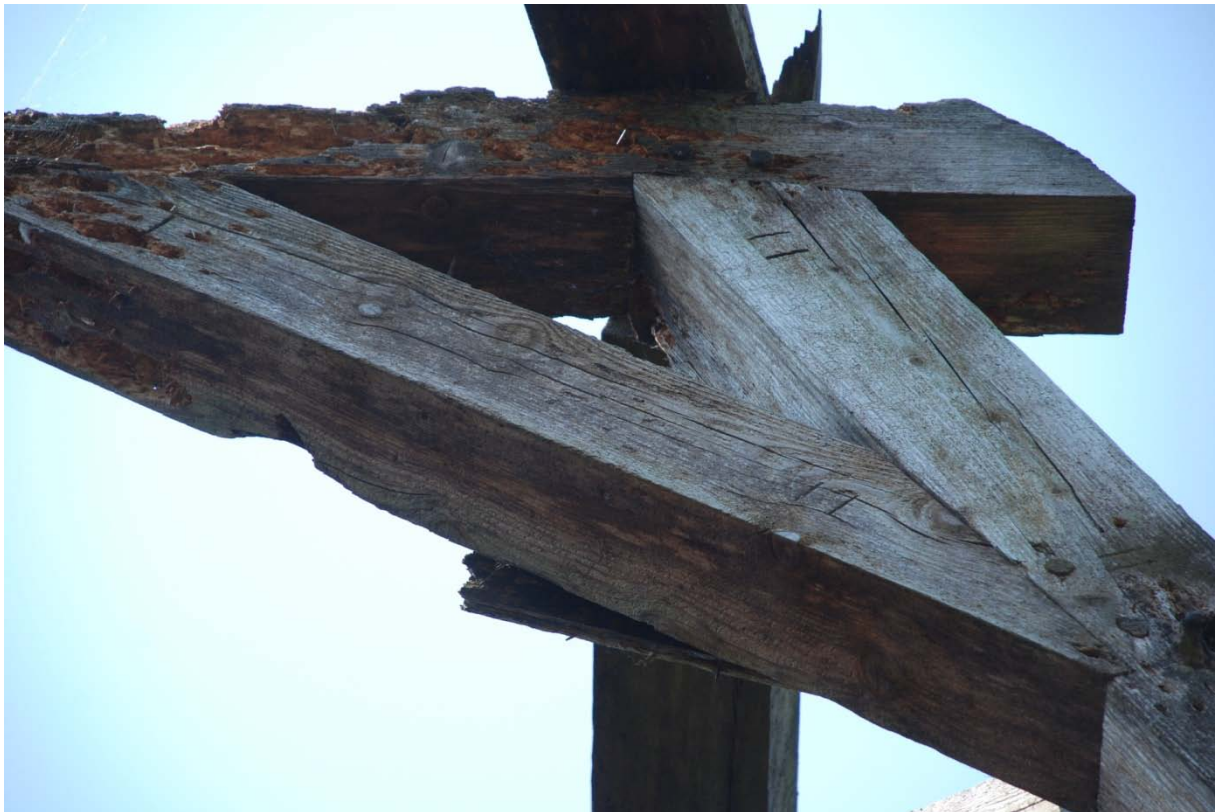
Afbeeldingen 9 en 10: De telmerken op het gebint en het juk II (nummer 2).
