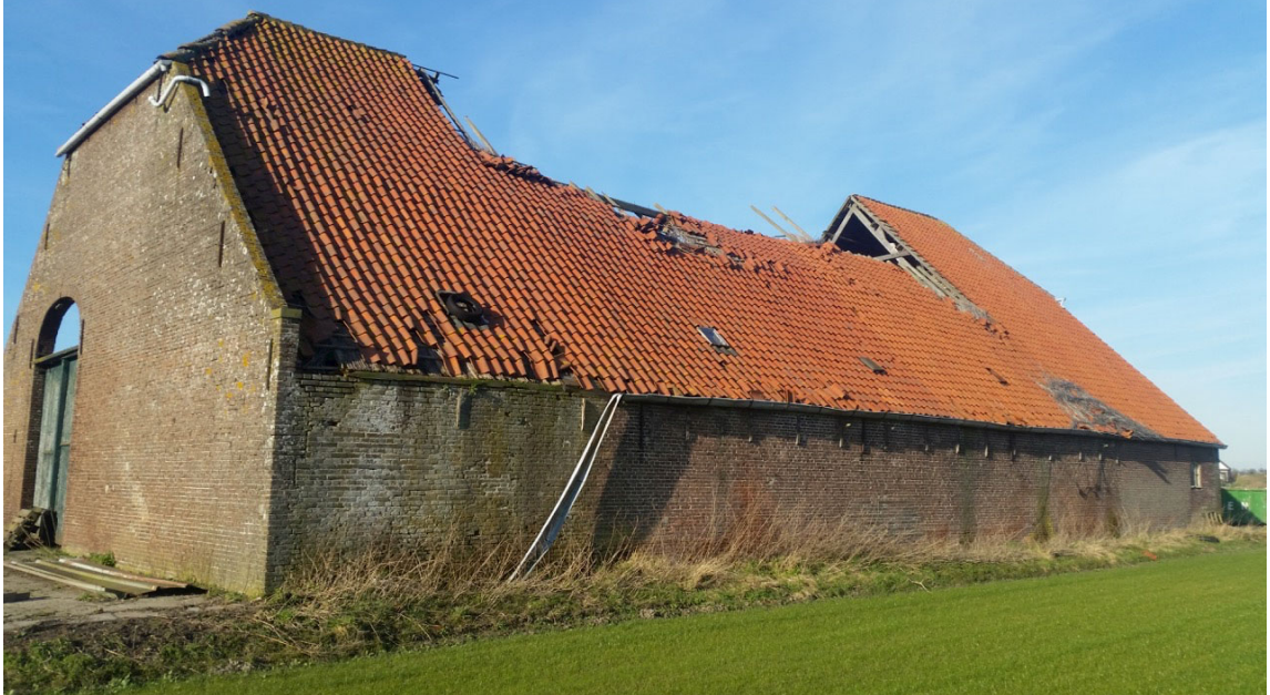
De schuur die wordt gerenoveerd en inpandig voorzien van een woning
