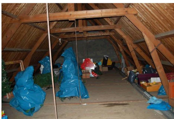
open zolders met opslag
