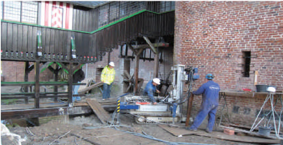
Afb. 3; Vervaardiging van schroefinjectpalen ter versteviging van de fundering van kasteel De Haar in Haarzuilens, provincie Utrecht.
