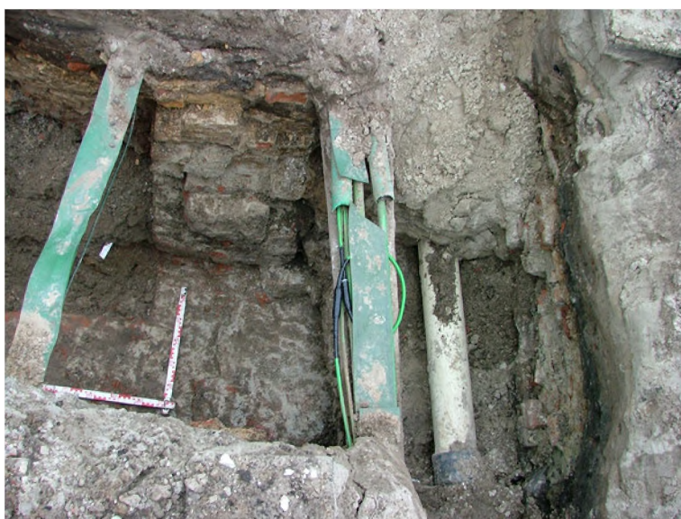
Figuur 9. Doorgebroken en kruisende muur. 04-04-2008.
