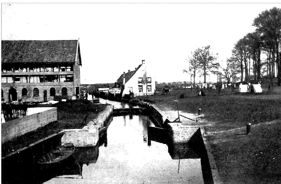
Figuur 13. Situatie rond 1910. Overzicht van de schutsluis in de Aa aan de Paarden- markt. Links de droogschuur van leerlooierij Van Dorsten, in het midden gebouw De Locomotief.
