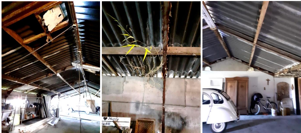
Binnenzijde stal met golfbeplating (geen isolatie)
