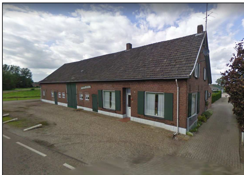
Figuur 5: Foto van de langgevelboerderij aan Driebokstraat 12
